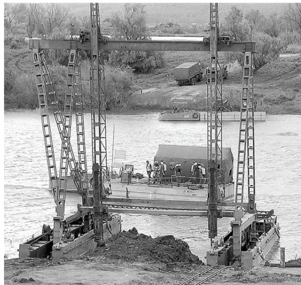
срок восстановить прерванное движение. Техническая разведка и водолазное отделение провели обследование разрушений мостовых конструкций – как наземной, так и подводной его частей. Был заменён один из пролётов моста. Кроме того, служащие железнодорожных войск продемонстрировали операцию по сооружению так называемого ложного
