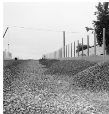
– Строительные работы близятся к завершению, – говорит начальник участка ТФ «Мостоотряд-36» Евгений Топехин. – Сейчас производится установка шумозащитных экранов, окраска металлических пролётных строений и железобетонных блоков, подготовка дорожной одежды под укладку асфальтобетонного покрытия. Параллельно идёт восстановление благоустройства на территории, озеленение.
